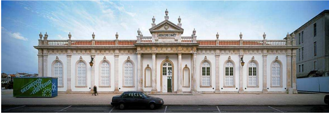
Fig. 3: O Laboratório Chimico, depois da intervenção do Séc. XXI (fotografia de Emanuel Brás)
