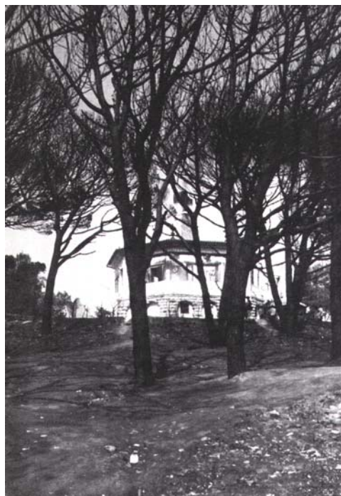
Fot. 1 - Alto da Vela (Serra da Boa Viagem). O Chalêt alguns dias após o incêndio.
