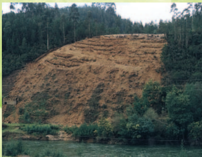
Penacova (Fev. 1996) - Margem direita do Rio Mondego, preparação do solo extremamente mal executado.
