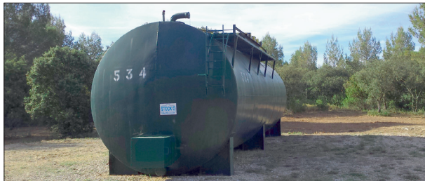
Fot. 21 - Citerne pour le ravitaillement en eau des pompiers (Source: C. Bouillon).
