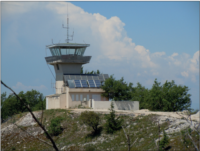
Fot. 19 - Tour de guet - Bouches du Rhône (Source: C. Bouillon). Photo 19 - Watchtower - Bouches du Rhône (Source: C. Bouillon).
