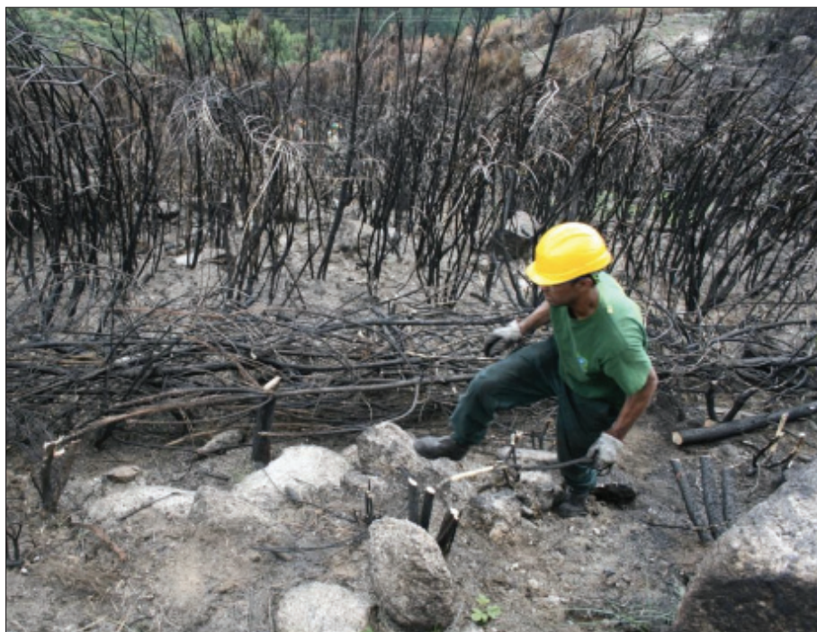
Fot. 2 - Pormenor da deposição da vegetação arbustiva no solo, orientada segundo as curvas de nível e com corte do material 30 cm acima do solo (Fonte: Mendes, 2011).
