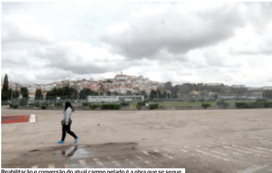
Reabilitação e conversão do atual campo pelado é a obra que se segue
