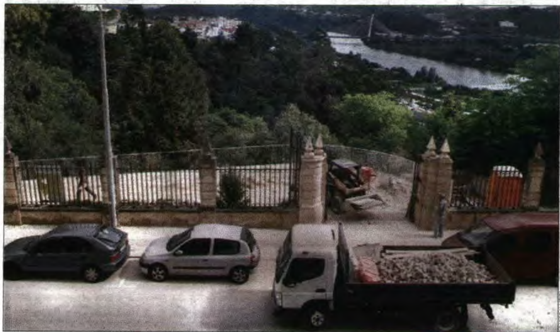
Obra sofreu atrasos devido à descoberta de vestígios arqueológicos
