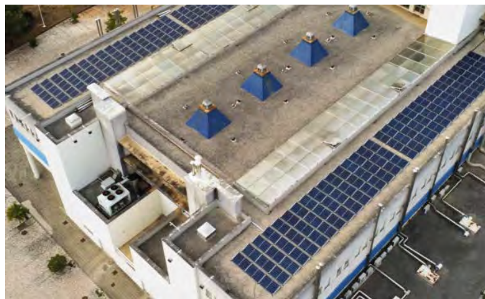
Figura 38. Instalação de painéis fotovoltaicos no Dep. de Eng. Química do Polo II
