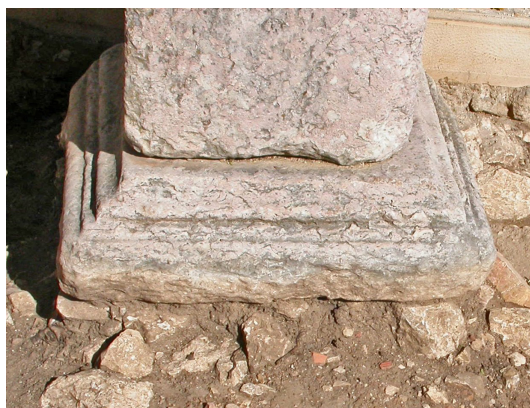
Fig. 3 - A imposta antes da construção do empedrado actual.
