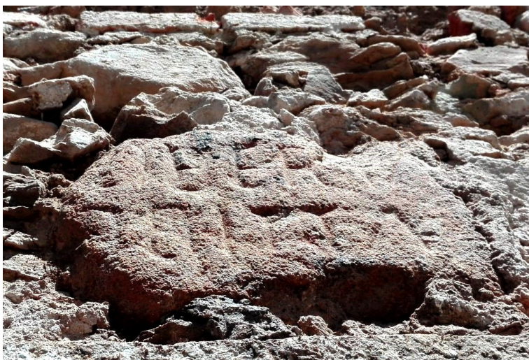
FIG. 2 – Estado de la última reutilización del epígrafe cuando se descubrió. © Remedios Corral
