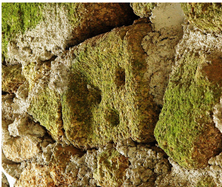
FIG. 2 — Cabecera de altar en la pared interior de la botilla. Foto: José Manuel Salgado (Fundación L. Monteagudo).
