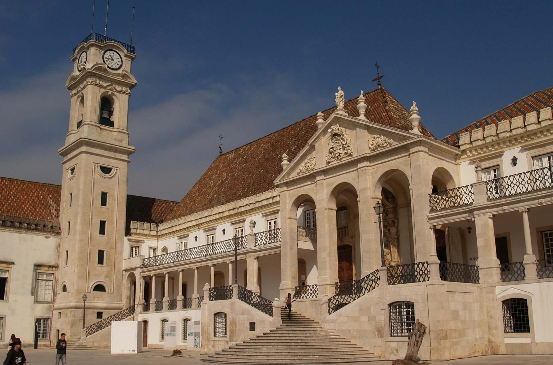
Obra de Restauro da Torre | Universidade de Coimbra | 2012
