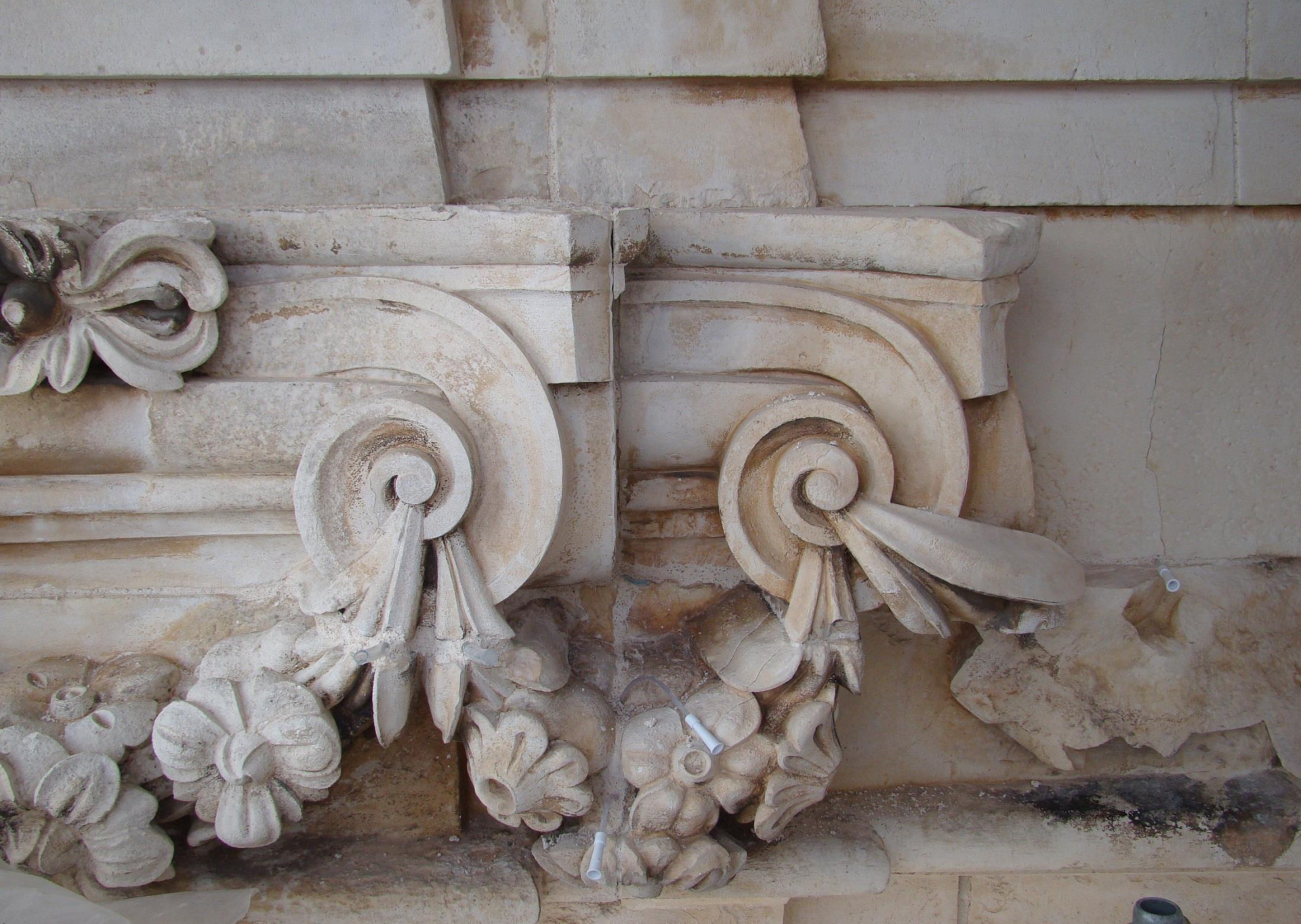
Obra de Restauro da Torre | Universidade de Coimbra | 2012
