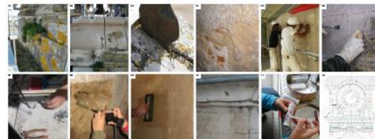
As imagens mostram as diferentes fases do trabalho de conservação e restauro da superfície pétrea da Torre. Desde a limpeza inicial até à aplicação dos materiais de conservação.
