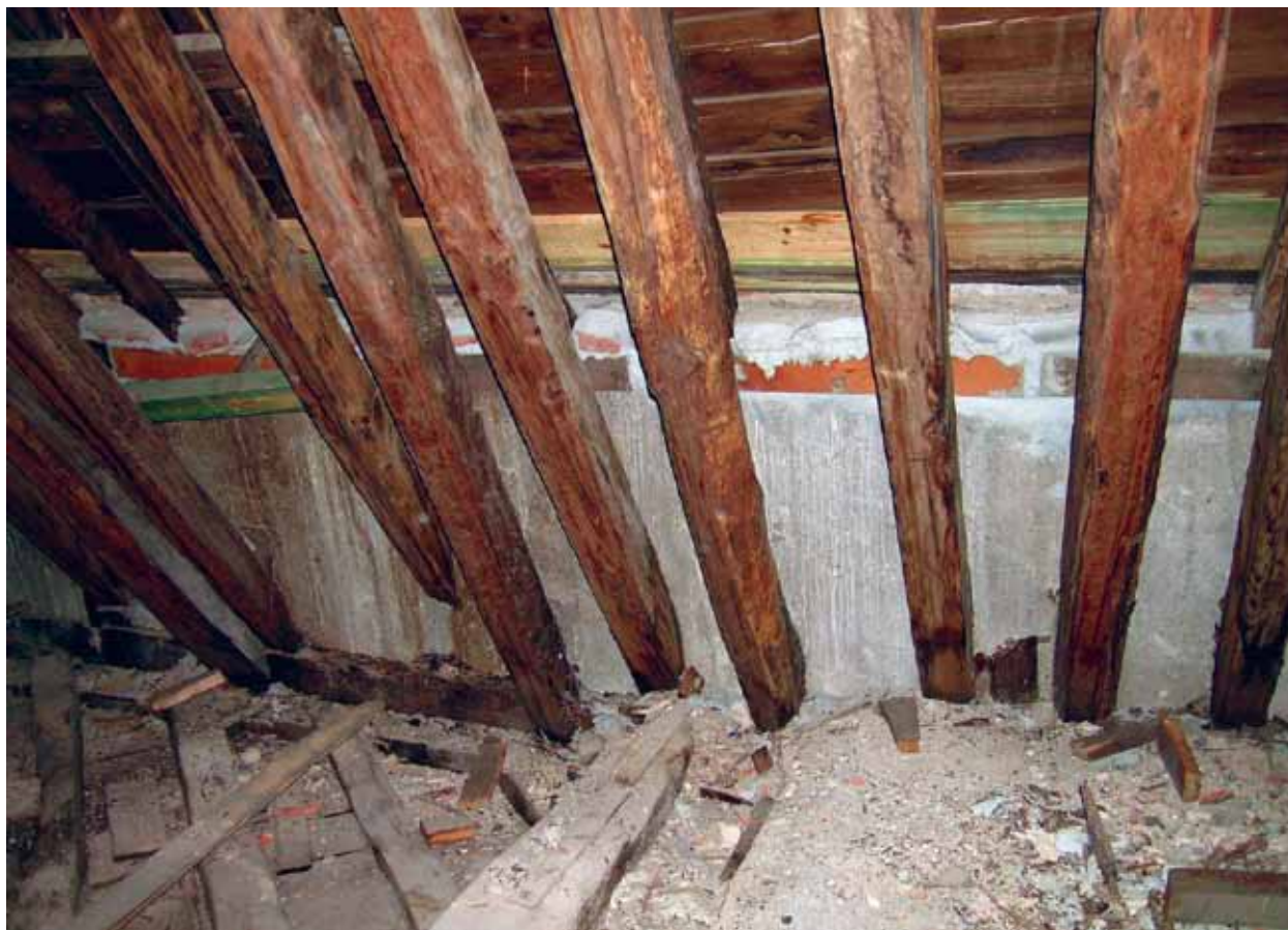
Desvão da cobertura da Sala dos Capelos com introdução de materiais de construção inadequados, AM, 2008 Garret under the roof of the Great Hall with introduction of inadequate building materials, AM, 2008
