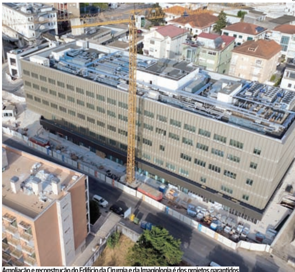
Ampliação e reconstrução do Edifício da Cirurgia e da Imagiologia é dos projetos garantidos
