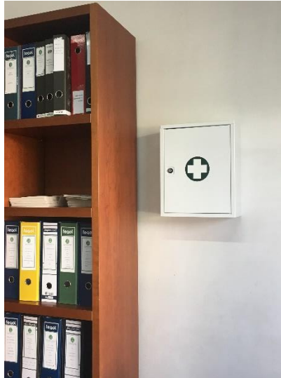
Figura 3.3.3.1 Armário de Primeiros Socorros instalado (Sede)
